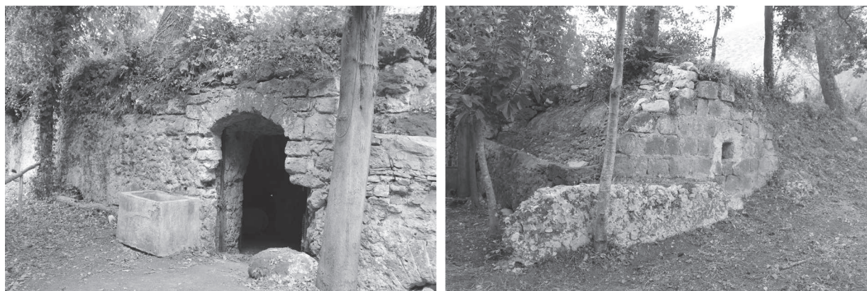
Fig. 26. Camigliano, cisterne in località Colonne Spezzate: ingresso moderno e lato sud-occidentale della struttura (da est).
