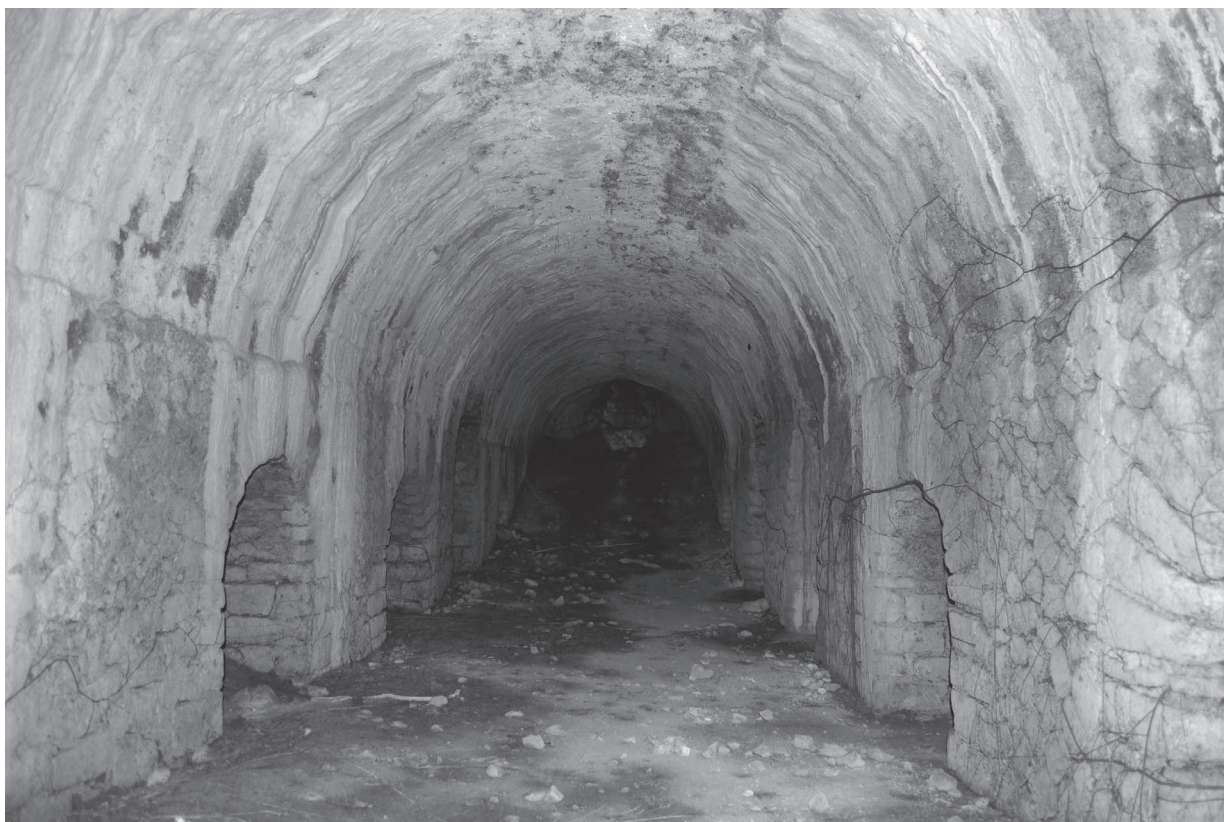
Fig. 30. Camigliano, cisterne in località Colonne Spezzate: la quinta camera (da ovest).
