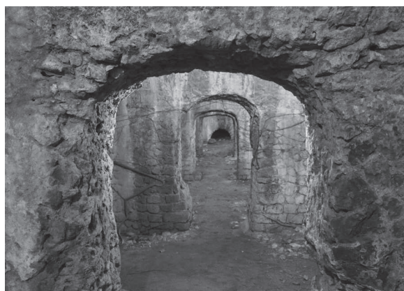
Fig. 28. Camigliano, cisterne in località Colonne Spezzate: la sequenza degli archi allargati in epoca moderna per consentire il passaggio nelle camere.
