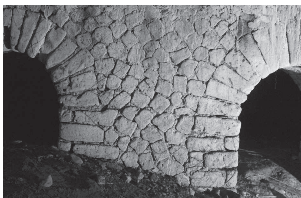
Fig. 31. Camigliano, cisterne in località Colonne Spezzate, quarta camera: dettaglio del paramento in opera incerta.
