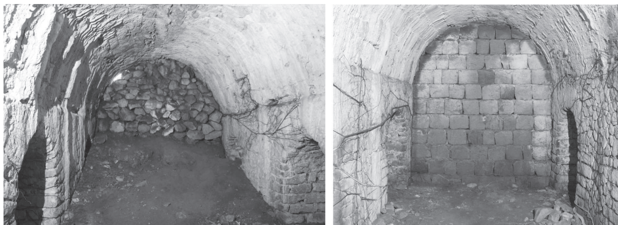
Fig. 27. Camigliano, cisterne in località Colonne Spezzate, terza camera. A destra: blocchi di calcare a chiusura del lato orientale. A sinistra: il muro moderno realizzato per la costruzione del pozzo.
