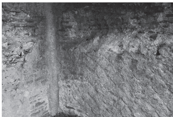
Fig. 18. Camigliano, Grotta di San Michele, cisterna della terrazza meridionale: paramento in opera reticolata con ricorsi in laterizi (sito 20b).
