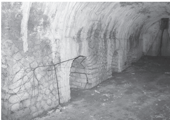
Fig. 35. Camigliano, cisterne in località Colonne Spezzate: dettaglio della muratura meridionale della quinta camera.
