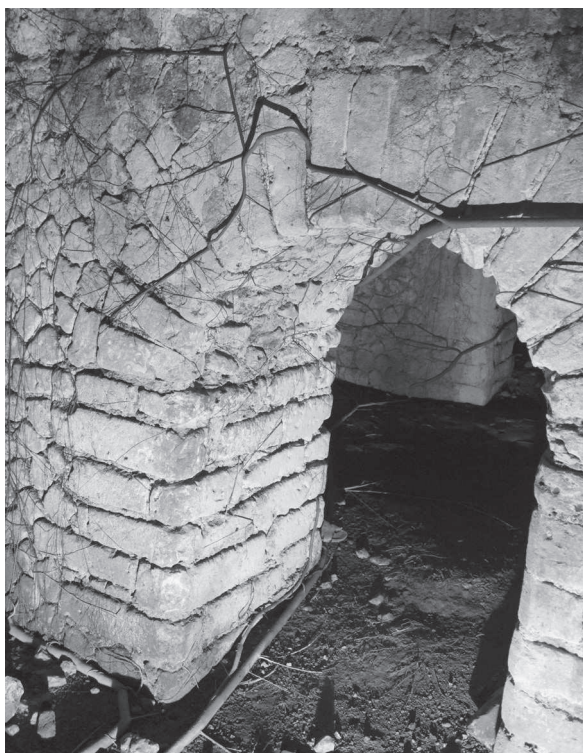
Fig. 32. Camigliano, cisterne in località Colonne Spezzate: dettaglio degli stipiti delle arcate della struttura.
