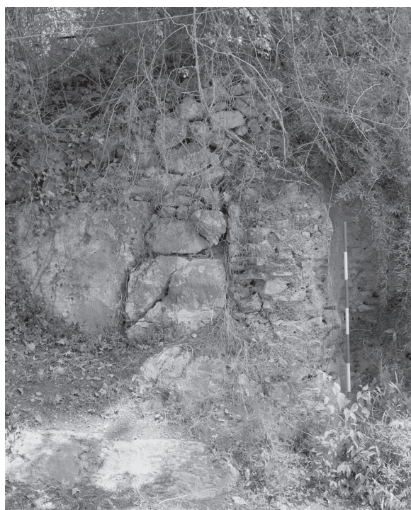
Fig. 19. Camigliano, Grotta di San Michele: rinforzo in blocchi di calcare del muro settentrionale della cisterna (sito 20b).
